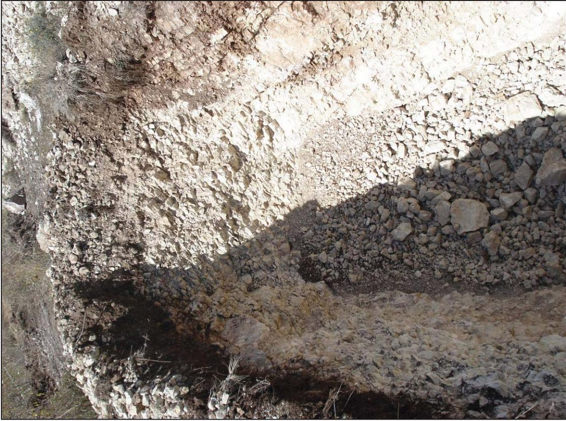
**Foto 2:** Scavo realizzato per la sistem azione di una fossa IMHOF. Dal le foto si pu ò osservare lo stat o di fatturazione dei calcari marnosi affioranti nel sito al di sotto di un sottile strato di terreno vegetale (0,30 m)
